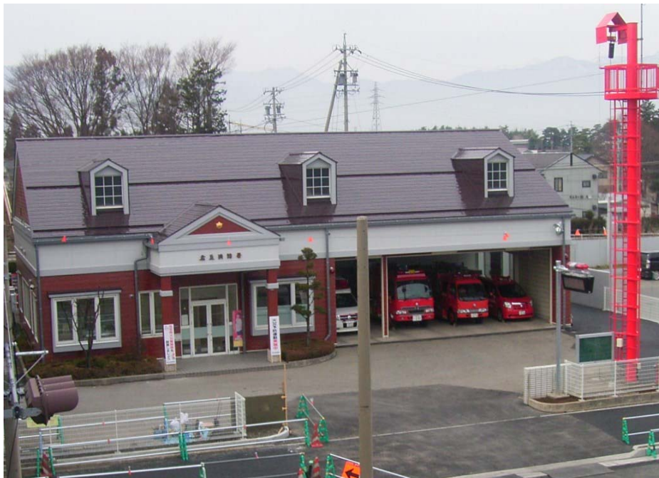
庁舎耐震化等改修工事完了した広丘消防署
