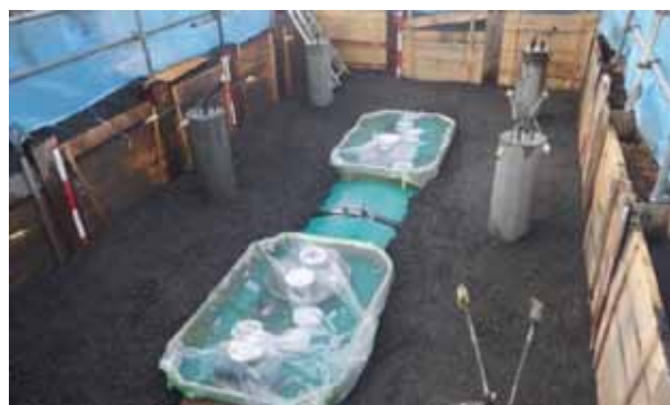
タンク埋め戻し
