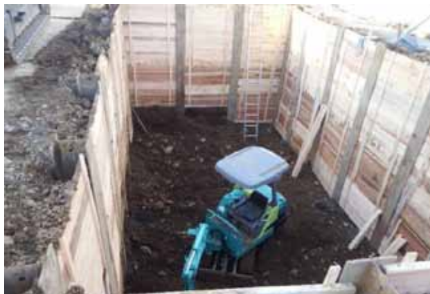
タンク埋設のため掘削
