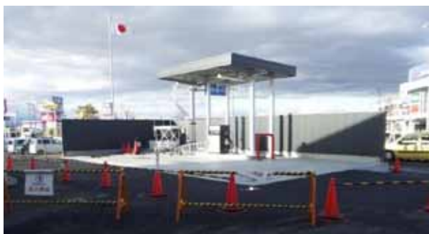
キャノピー・防火壁完成、計量器設置
