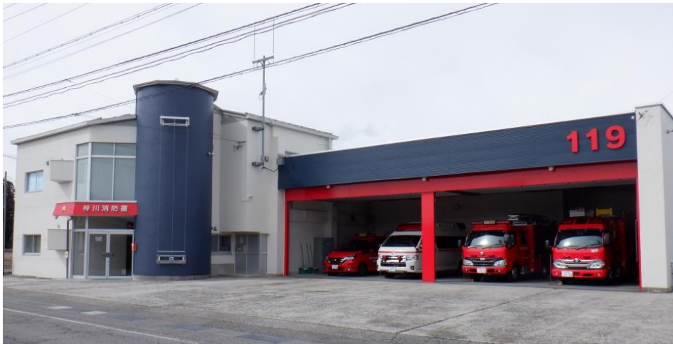
梓川消防署 改修工事：（令和7年1月竣工）
