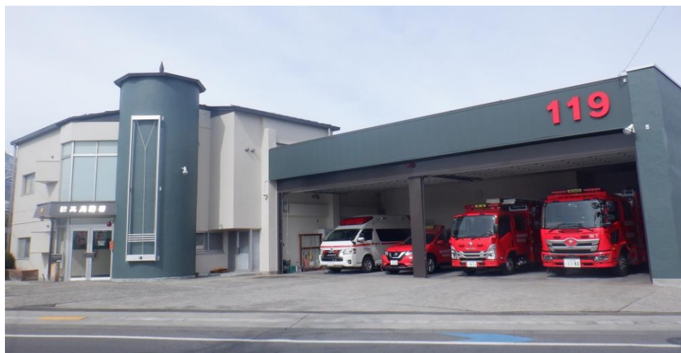
穂高消防署 改修工事：（令和7年2月竣工）
